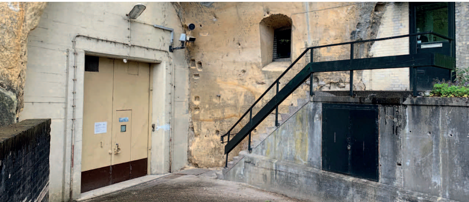
Ingang voormalig NAVO-hoofdkwartier in de mergelgrotten van de Cannerberg bij Maastricht. In gebruik van 1963-1992 en na een jarenlange sanering opengesteld voor publiek.
