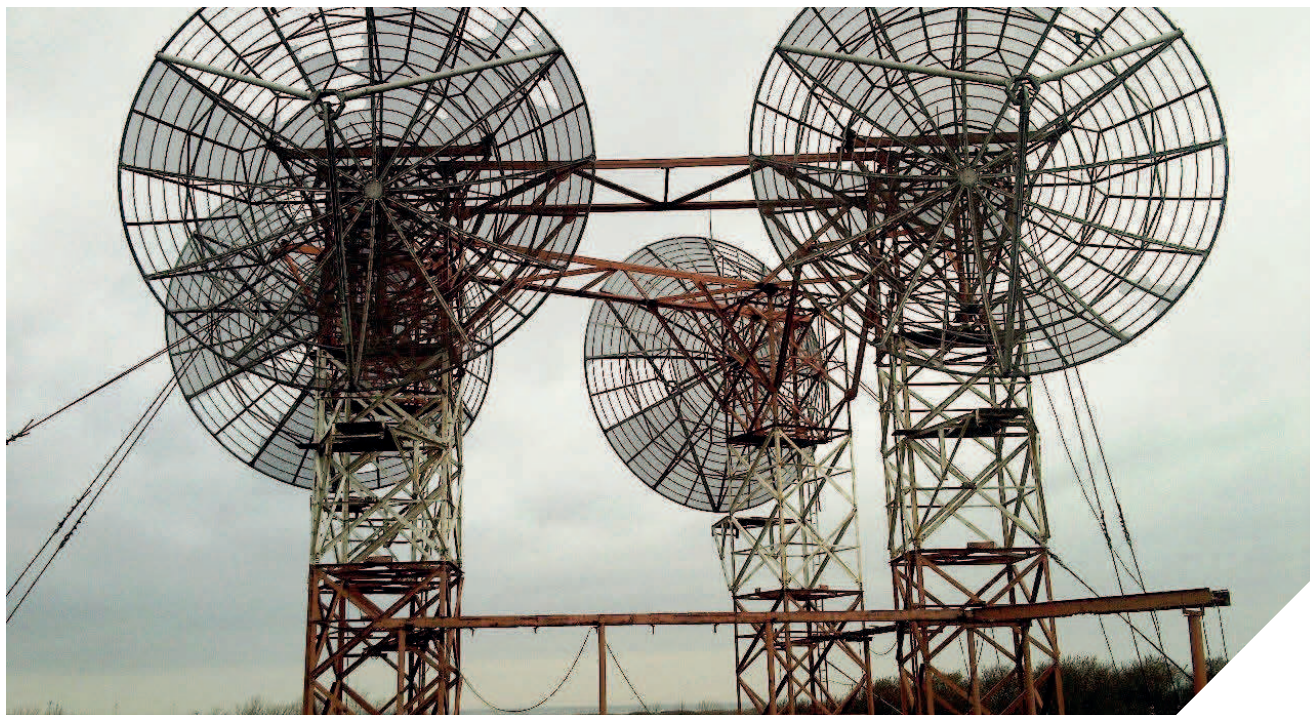
Straalzender met paraboolantennes (1967) voor geheim berichtenverkeer tussen Europa en Amerika.
