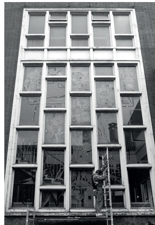
De sierramen van Wim Wagemans in situ en na de herplaatsing.
