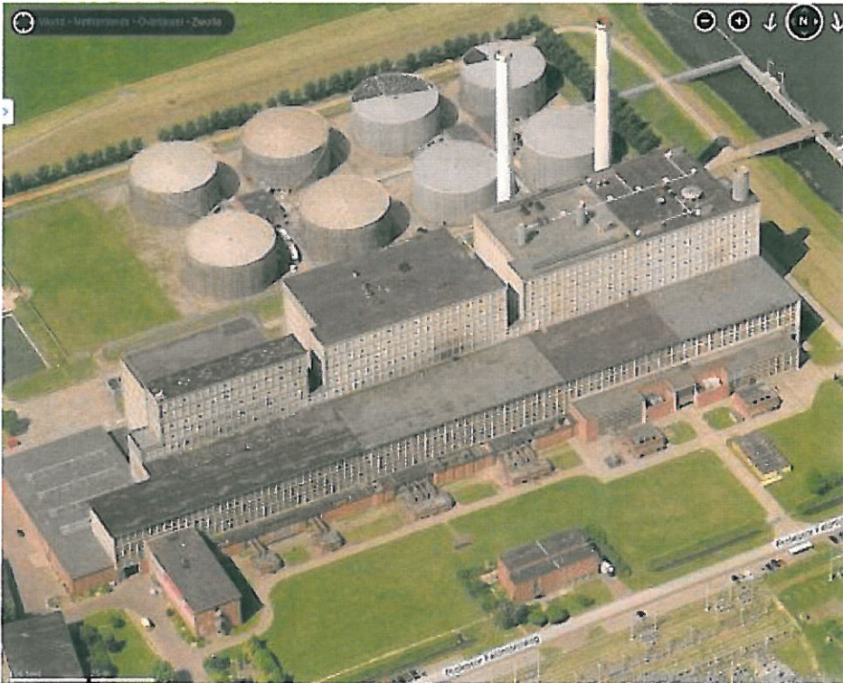
De centrale 'Harculo' / IJsselcentrale in Zwolle: een monumentaal gebouw
