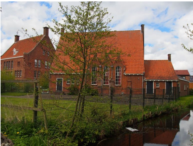
Foto Bond Heemschut – mei 2017 Kerkgebouw Kievitstraat 3 Grou recht, voormalig raadshuis Idaarderaal rijksmonument links
