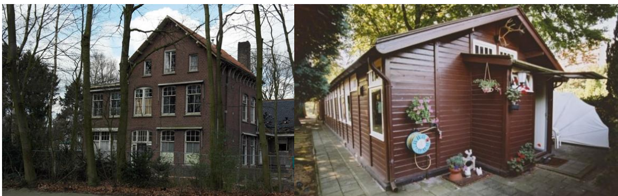
Het inmiddels gesloopte MGD gebouw en particuliere bewoning van één van de ziekenbarakken.
